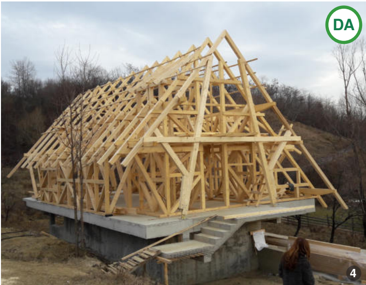
AȘA DA: Construcție nouă, a cărei structură este realizată integral din lemn.
