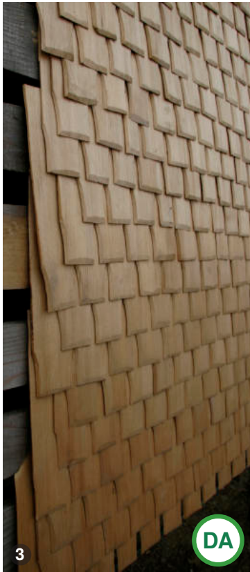
AȘA DA: Șindrila tradițională este o soluție recomandată, atât pentru înlocuirea învelitorilor istorice degradate, cât și pentru construcțiile noi.
