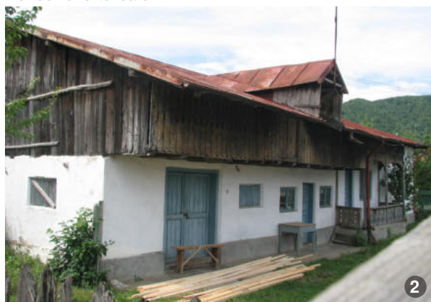
Clădire anexă cu partea inferioară din zidărie care permite izolarea termică iar partea superioară din lemn.
