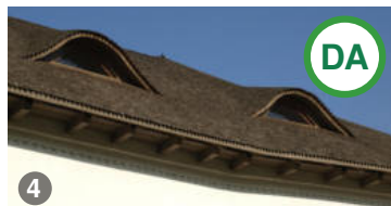
ASA DA: Micile lucarne amenajate în mansarda unei clădiri pot aduce suficientă lumină pentru spații precum dormitoare, băi etc. Acest tip de lucarnă poate fi folosit cu condiția ca dimensiunea lor să rămână în limita valorilor decente.
