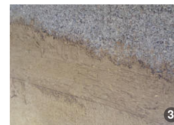
ASA DA: Pereți cu termoizolație din Hempcrete.
