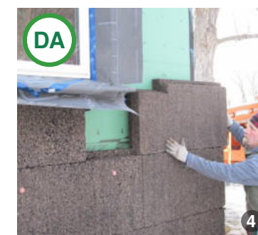
ASA DA: Plăci izolatoare din plută expandată
