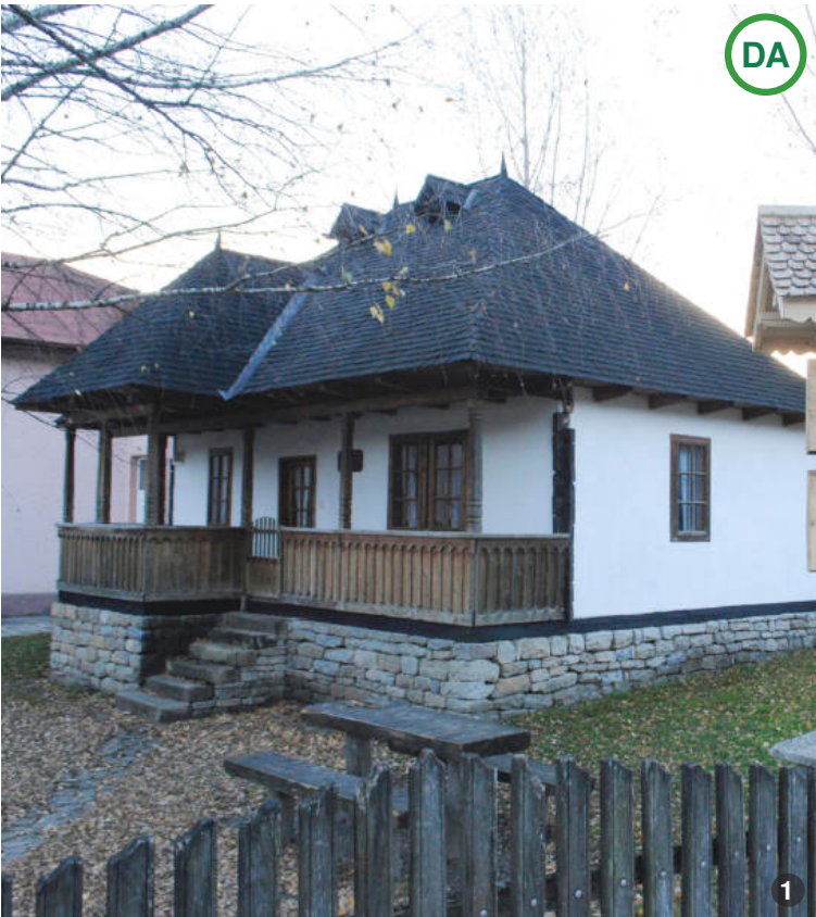
ASA DA: Exemplu de zidărie de piatră pentru soclu.
