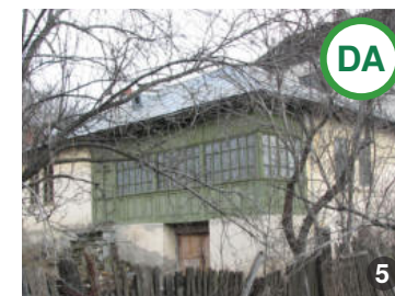
AȘA DA: Prispa poate fi închisă cu o suprafață vitrată dar sub formă de geamlăc, adică folosind tâmplărie de lemn cu goluri mici de maxim 25 x 35 cm.
