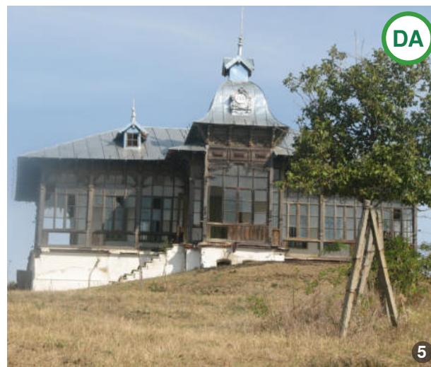
ASA DA: Exemplu de închidere a spațiului unei prispe de dimensiuni mai mari. Acest model de împărțire a foilor de geam este recomandat pentru scara firească pe care o creează chiar și atunci când este vorba de lungimi mari.
