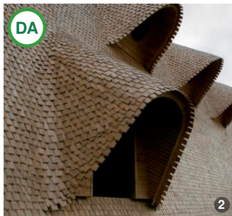
AȘA DA: Iluminarea prin lucarne la o construcție nouă care folosește șindrii.
