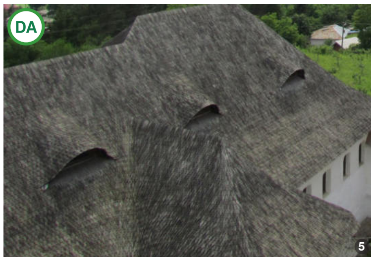
AȘA DA: Clădire cu gabarit mare unde s-a utilizat învelitoare de șindrilă. Este de remarcat importanța unei învelitori istorice în peisajul satelor. Poate fi utilizată și pentru diverse funcțiuni care necesită o suprafață construită mare: pensiuni, școli, birouri, clădiri administrative, centre culturale etc.
