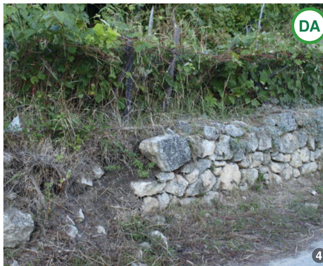
AȘA DA: În zonele cu acces facil la carierele de piatră sau la albiile râurilor, s-a folosit preponderent piatra pentru zidurile clădirilor și a zidurilor de sprijin.
