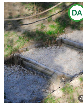
AȘA DA: Scări exterioare cu trepte din piatră și contratrepte din lemn rotund despicat care se pretează pentru amenajări exterioare.
