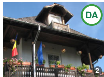
ASA DA: Lucarna de formă rectangulară este o soluție de iluminare a mansardei atât la clădirile acoperite cu șindrilă, tablă cât și țiglă.
