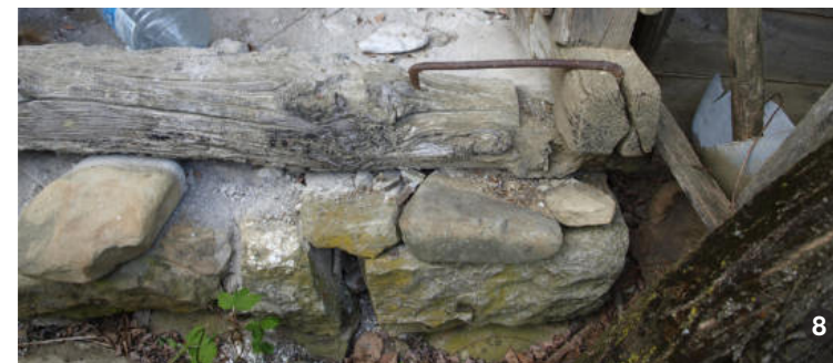
Fundație și soclu de piatră.
