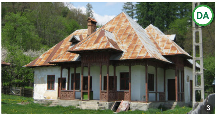
AȘA DA: Utilizarea unui acoperiș cu patru ape ce acoperă o clădire de formă dreptunghiulară, cu decroșuri care se citesc mai mult în planul acoperișului, dinamizează cu rafinament poziția volumetrică.
