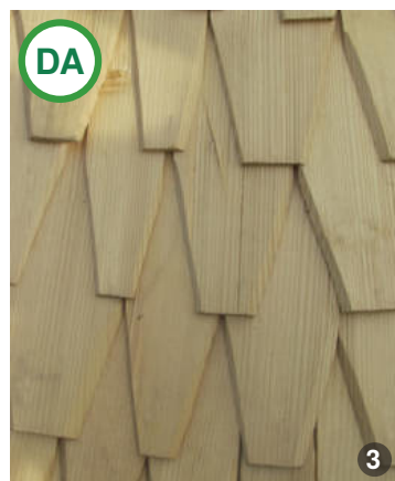
AȘA DA: Șindrilă tradițională din zona Prahova.
