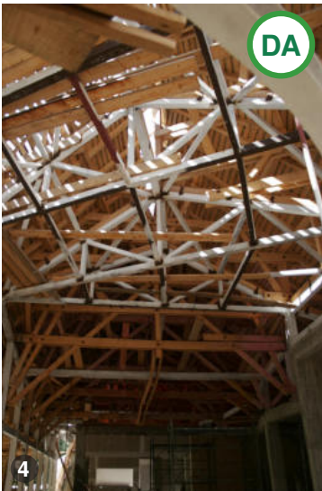
AȘA DA: Pentru construcții cu deschideri mari se pot folosi sisteme combinate de metal cu lemn.
