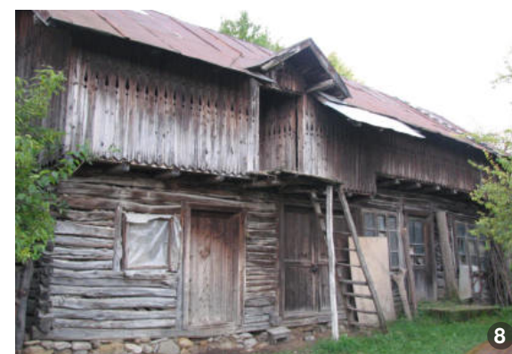
Anexe tradiționale realizate cu elemente din lemn cioplite cu barda, tehnică veche de sute de ani, de aceea clădirile sunt foarte valoroase.
