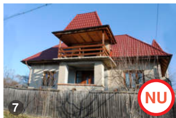
ASA NU: Învelitoarea din tablă profilată nu se potrivește în contextul clădirilor tradiționale sau a construcțiilor noi din mediul rural chiar dacă se montează într-o culoare adecvată.
