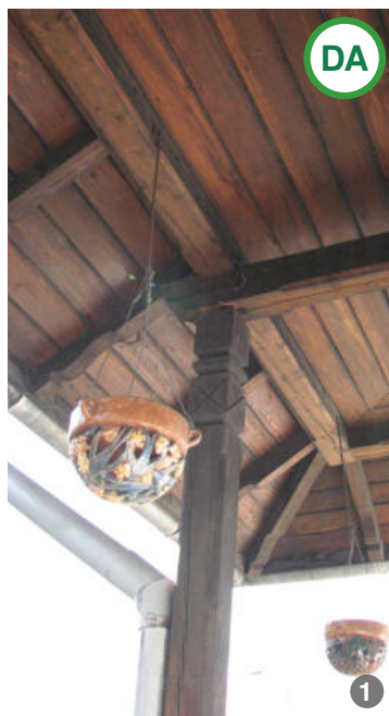
AȘA DA: Realizarea streșinii din lemn după dimensiunile locale este varianta optimă pentru clădirile de orice dimensiune.
