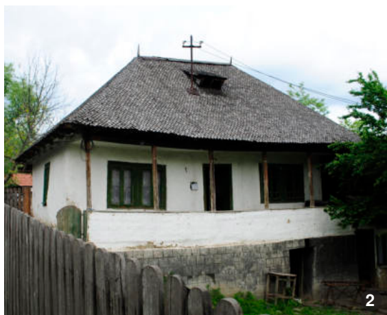
Construcții cu acoperiș cu patru ape, cu învelitoare din șindrilă.
