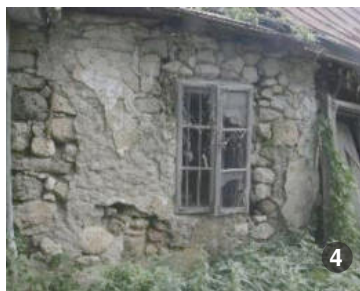
Zidărie din piatră.
