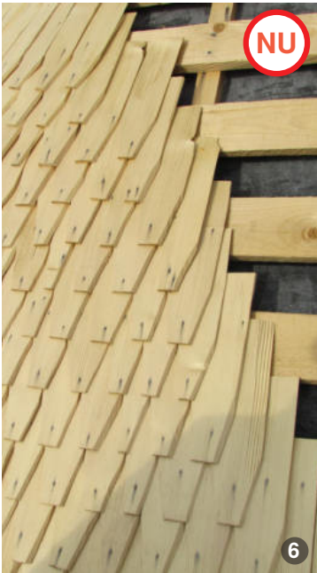
AȘA NU: Șindrila care are cui la vedere este mai puțin durabilă în timp mai ales dacă nu se ține cont de dilatarea pieselor de șindrilă.
