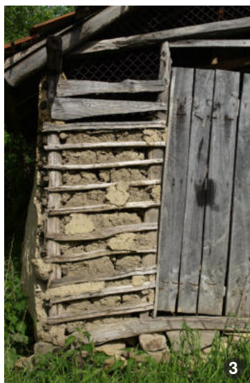
Detaliu schelet din pari de lemn înfipt în pământ cu șipci și umplutură de pământ.
