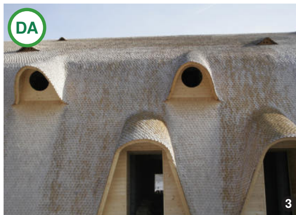
AȘA DA: Șindrii nouă utilizată la o pensiune turistică.
