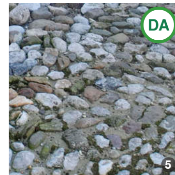
AȘA DA: Exemplu de trotuar de gardă.
