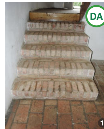
AȘA DA: Realizarea treptelor și a pardoselii din cărămidă.
