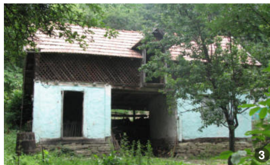
Anexă realizată din materiale tradiționale, care poate fi folosită ca extindere la o construcție existentă. Aceasta poate fi un exemplu de legătură între două corpuri de clădire, lăsând o deschidere vizuală către grădină.
