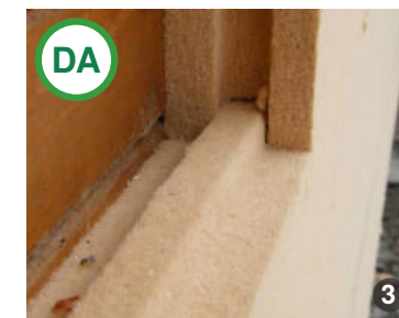
ASA DA: Termoizolație fibrolemnnoasă. Produs fabricat din materii prime naturale, utilizând tehnologii moderne și prietenoase cu mediul. Fiind permeabilă la vaporii de apă, păstrează structura casei în stare uscată în mod permanent. Poate fi utilizată pentru fațadă, pardoseli și mansarde.
