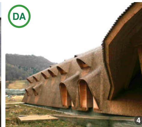
AȘA DA: Clădire nouă cu gabarit mare care poate constitui un mod de a acoperi construcții cu gabarit mare folosind acoperiș cu patru ape și învelitoarea din șindrilă.
