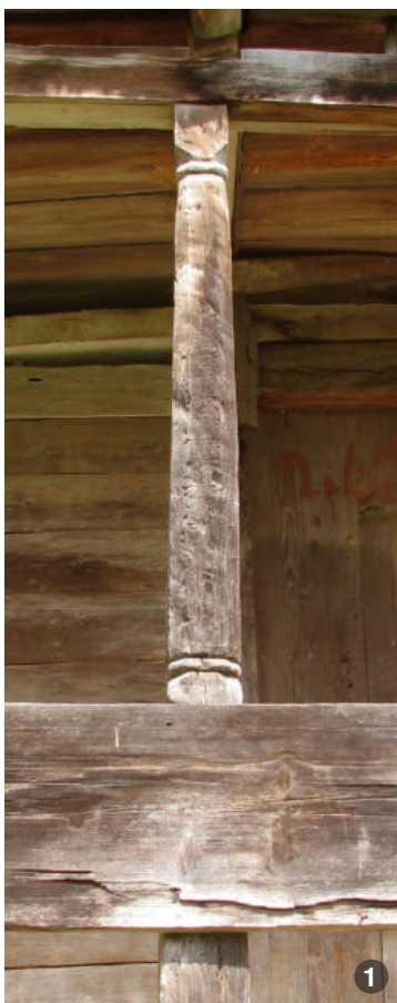
Stâlpii sculptați manual cu barda aparțin celor mai valoroase exemplare ale arhitecturii tradiționale.
