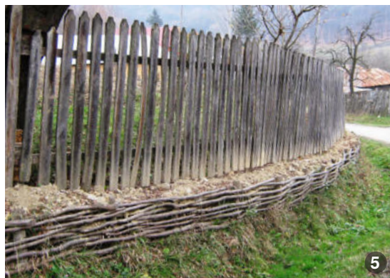
Zid de sprijin din împletitură de nuiel și împrejmuire din lemn.
